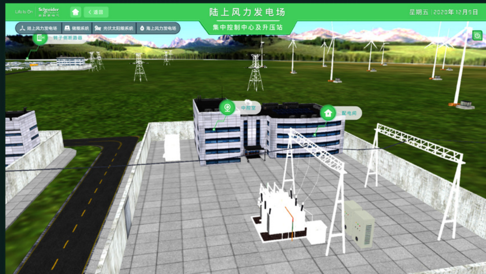
集中控制中心与升压站
